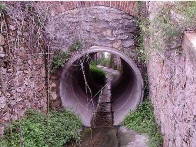
**Figura 9: passaggio in corrispondenza del rilevato ferroviario**
